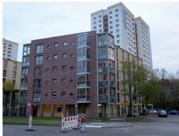
Bauliche Ergänzung im gewohnten Maßstab
