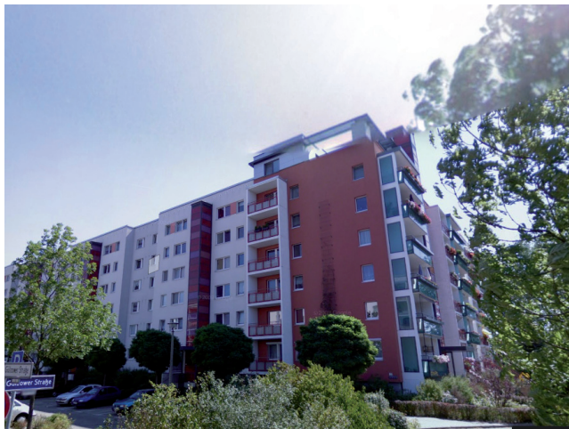
Eckbebauung zweier Brandwände
